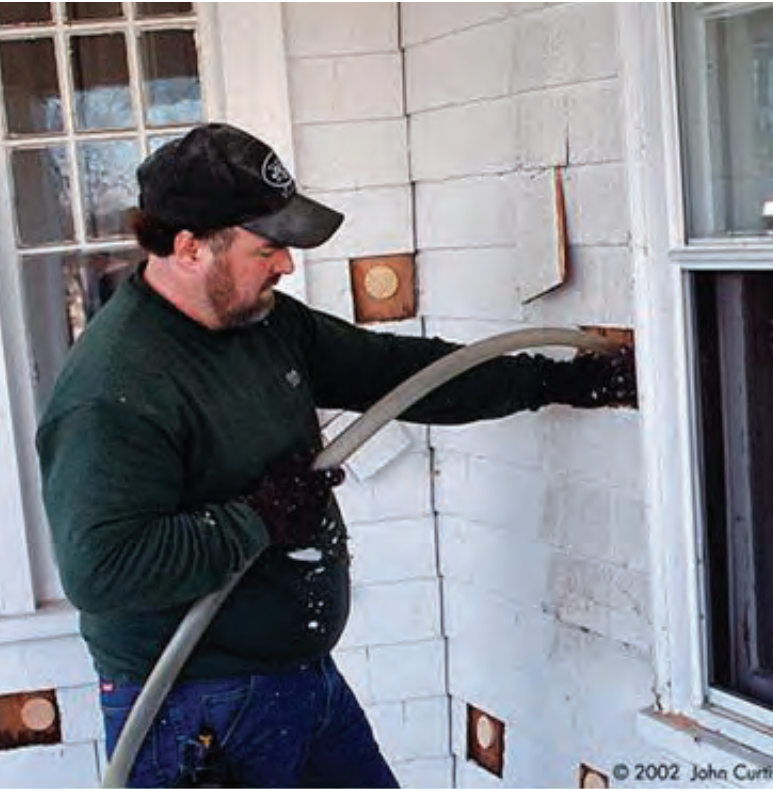
Exterior wall fill tube.
