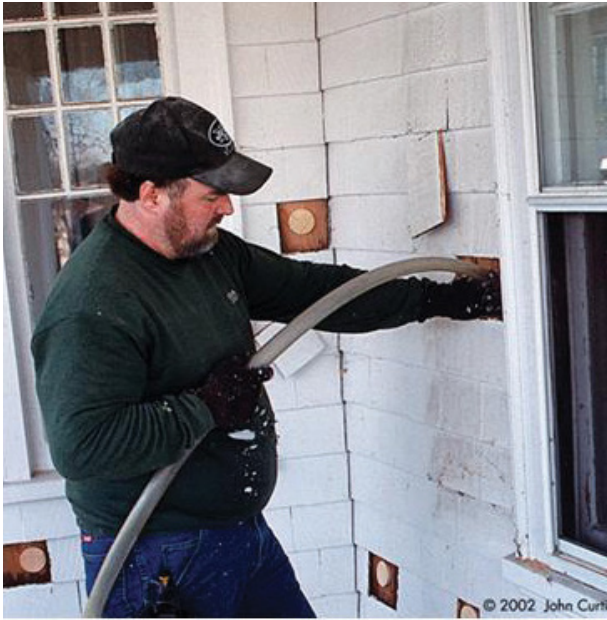
Exterior wall fill tube.
